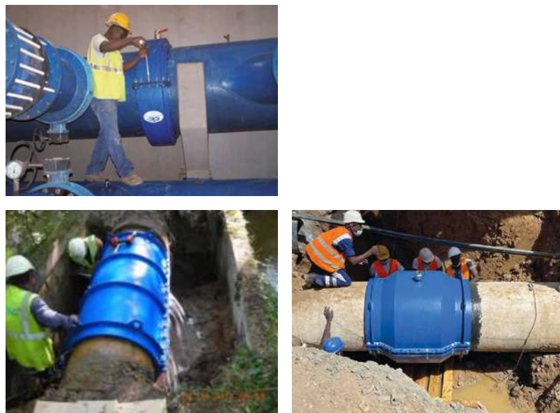
Réparation de conduites grandes dimensions sur réseau enterré ou en station de pompage.
