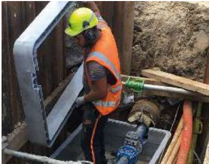
Installation chambre modulaire
