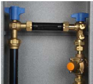
Montage avec réducteur de pression
