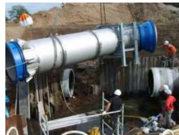
Rénovation de réseau par le raccordement de différents tuyaux et ouvrages.
