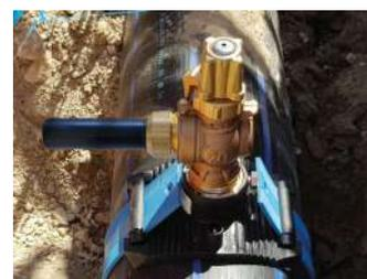
Les colliers électrosoudables s'installent sur les conduites en PE. Le montage sur la canalisation est réalisé par électrosoudure, à l'aide d'une machine dédiée. Il existe des modèles monodiamètres ou multidiamètres.
