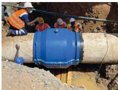
Réparation de conduites grandes dimensions sur réseau enterré ou en station de pompage.
