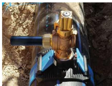
Associez le robinet de prise en charge 2038 au collier Omegaflex et optez pour une solution de branchement hybride pour la gestion patrimoniale des réseaux PE.
