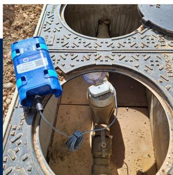
Logger BLUE, installé sur compteur d'eau privé
