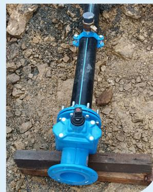
*Pose de 2 branchements en charge : le premier permet d'insérer le ballon obturateur ABS dans la canalisation, le second pour réaliser la purge côté aval. Entre les 2 branchements, un collier de maintien est installé pour tenir la canalisation en place. Une fois la purge effectuée, la vanne de sectionnement est posée et le nouveau bâtiment alimenté en eau.*
